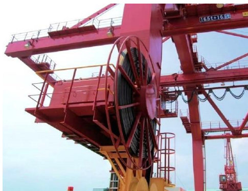
ケーブルリール (給電機器)
